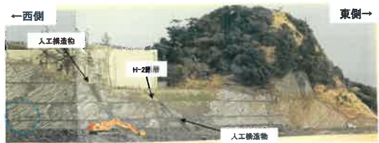
4号機建屋周辺斜面写真(その2)
