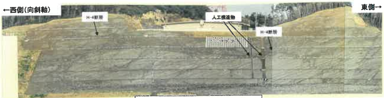
4号機建屋周辺斜面写真(その1)
